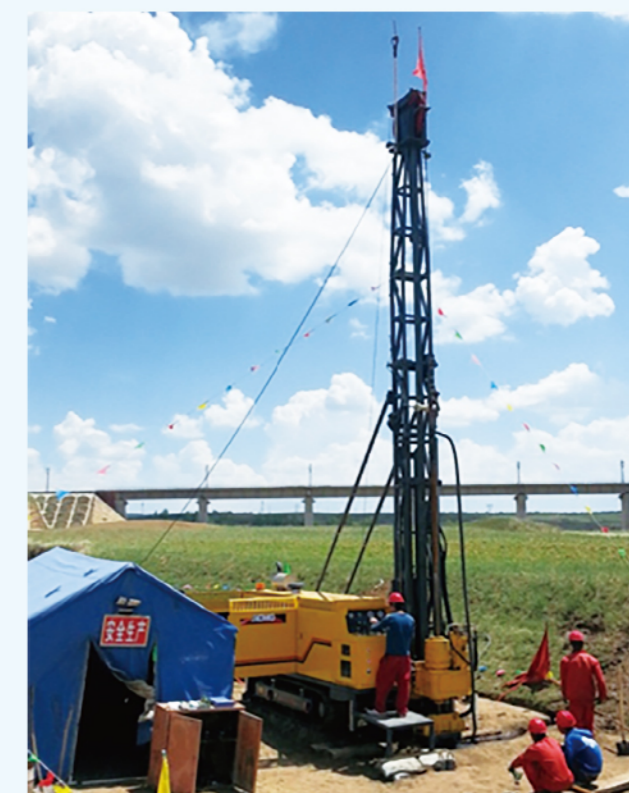
XDY1500全液压岩心钻机在大同施工 XDY1500 Working site in Datong
